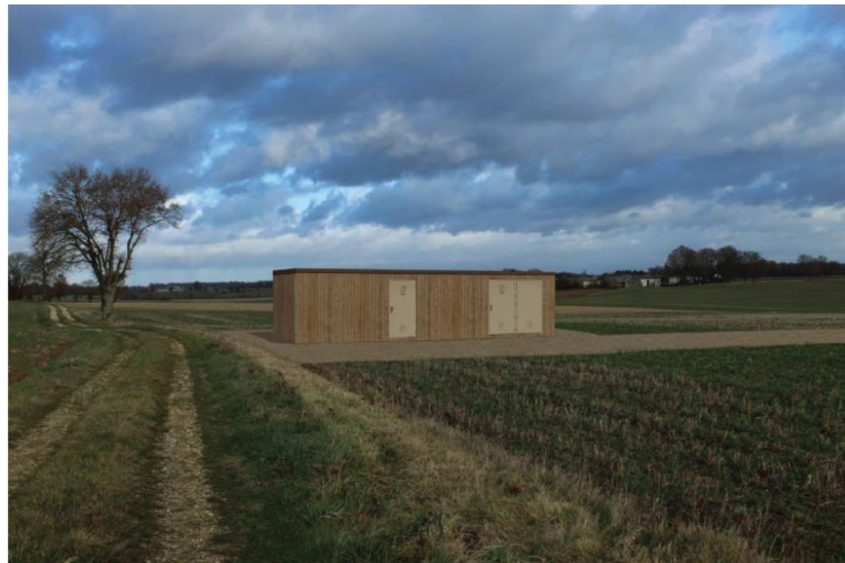
Intégration paysagère du poste de livraison
